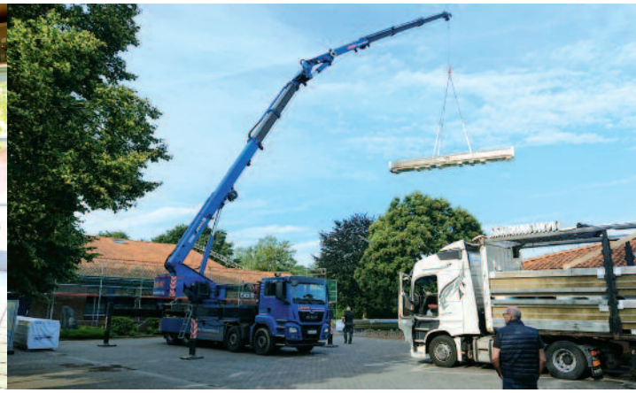
Schweres Gerät bei der Materialanlieferung für das neue Dach.
